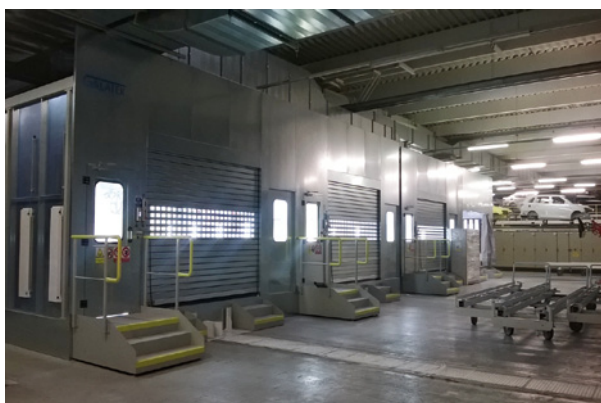
3x stříkácí kabina Spotrepair, 1x pracoviště auditu - 2
