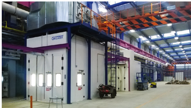
Celkový pohled na pracoviště
