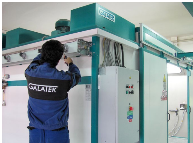
Výměna elektromagnetického ventilu
