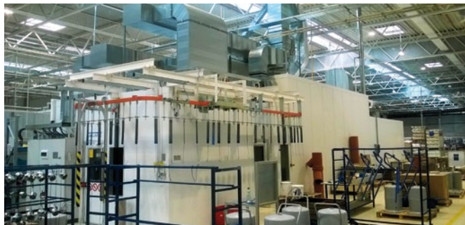
Linka pro automatické lakování dílů pro firmu PRESSOL Tschechien s.r.o., Tachov
