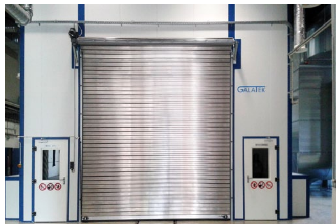
Stříkáací kabina se vzduchotechnickou jednotkou pro firmu Dopravní podnik, Praha
