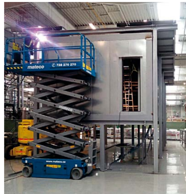
Průběh montáže sušárny
