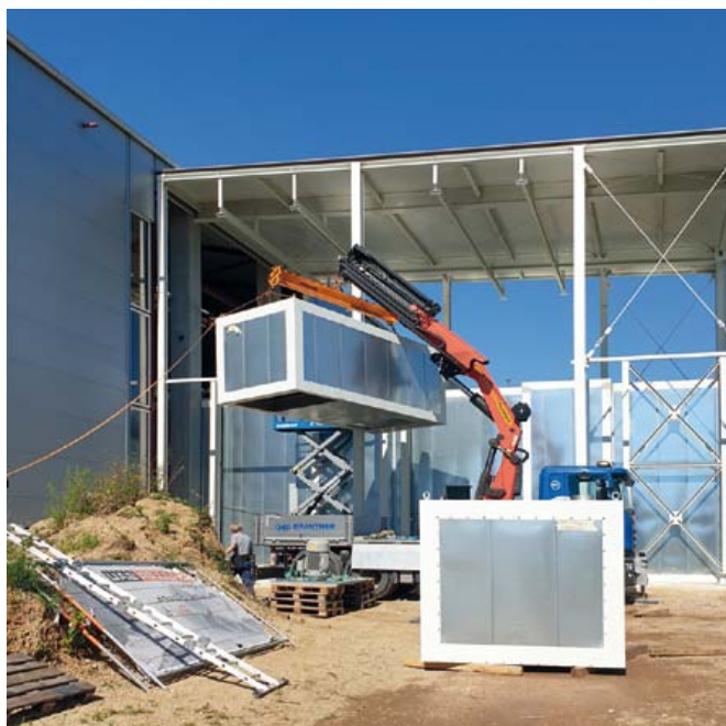
Průběh montáže vytvrzovací pece ve firmě Hans Brantner
