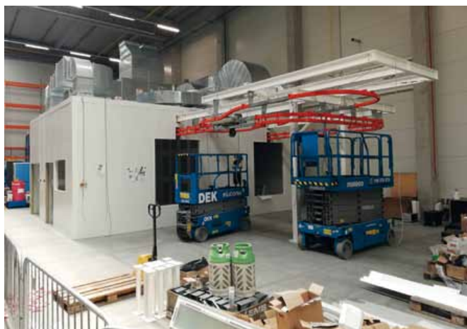
Průběh montáže na pracovišti
