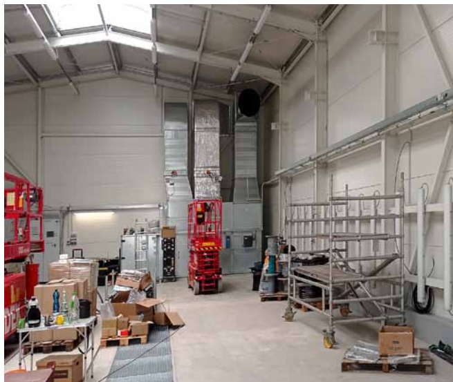
Montáž na pracovišti
