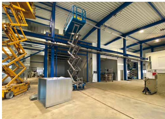
Montáž na pracovišti
