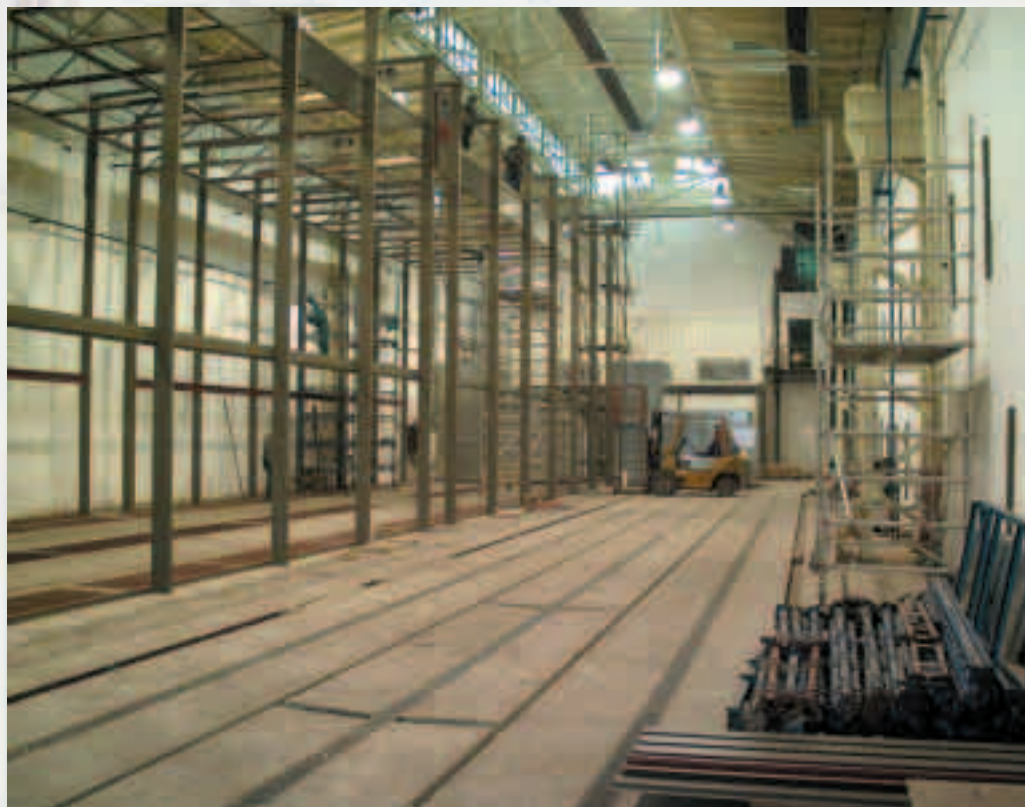
Probíhající montáž a stavební práce
