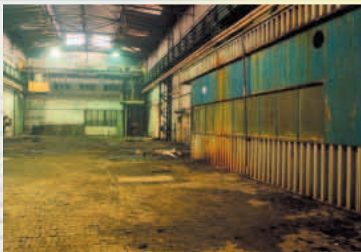
Výchozí stav haly v prosinci 2001
