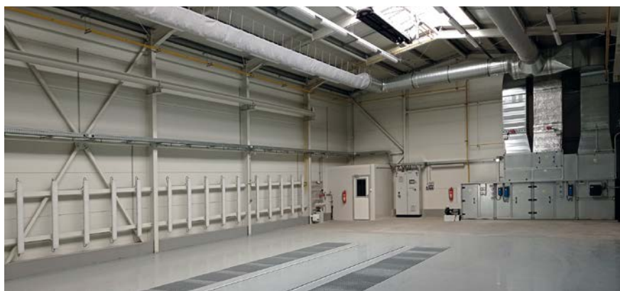
Pohled do haly včetně vzduchotechniky
