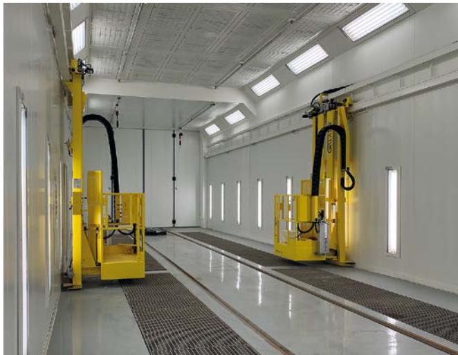
Původní kabina po rekonstrukci
