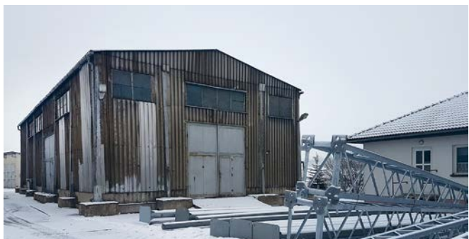
Původní objekt před rekonstrukcí
