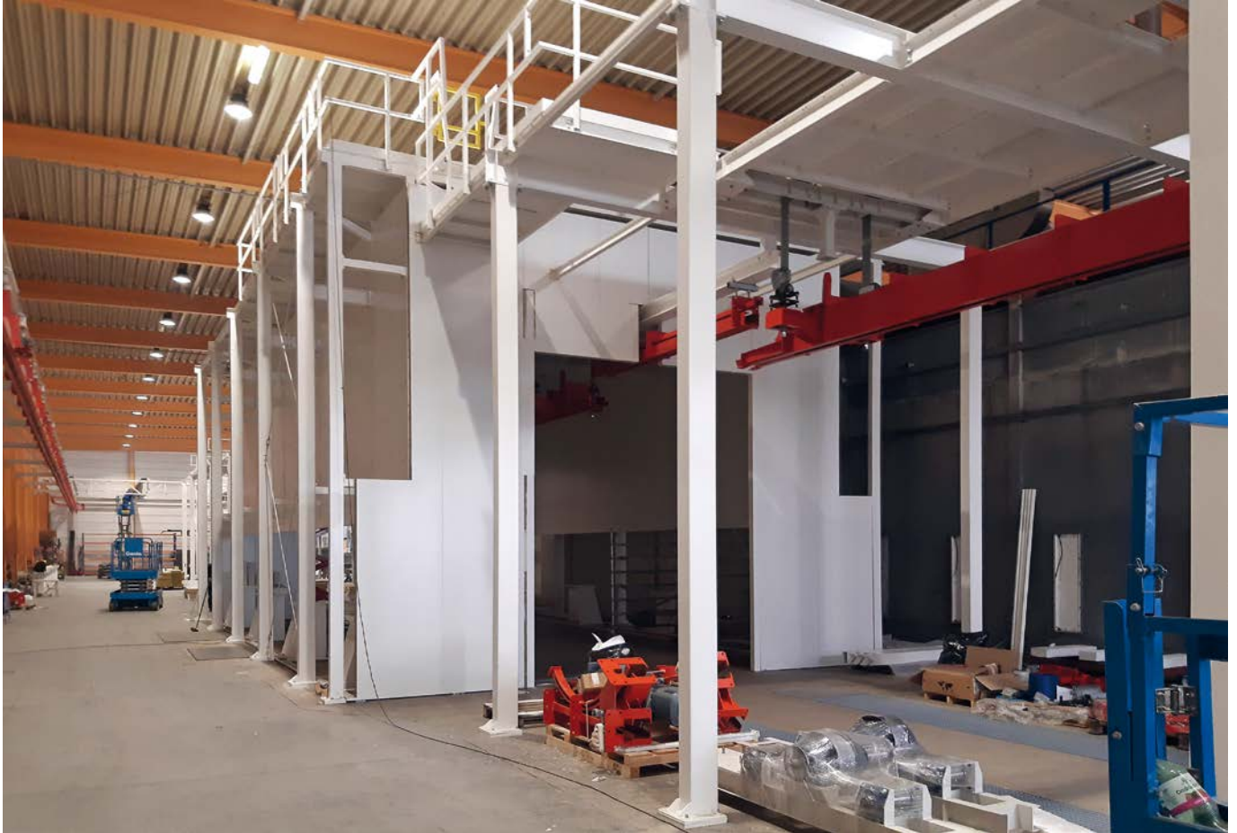
Průběh montáže lakovací linky
