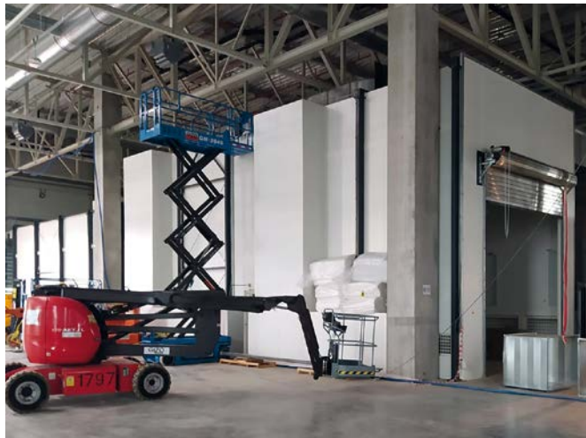
Průběh montáže lakovací kabiny
