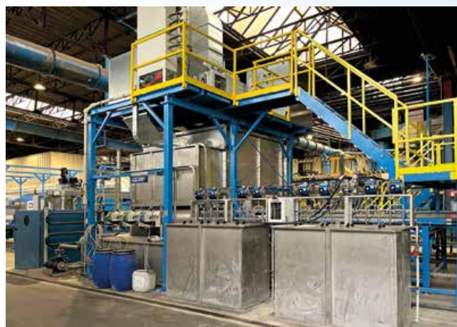
Lakovací kabina pro lakování izolačních desek
