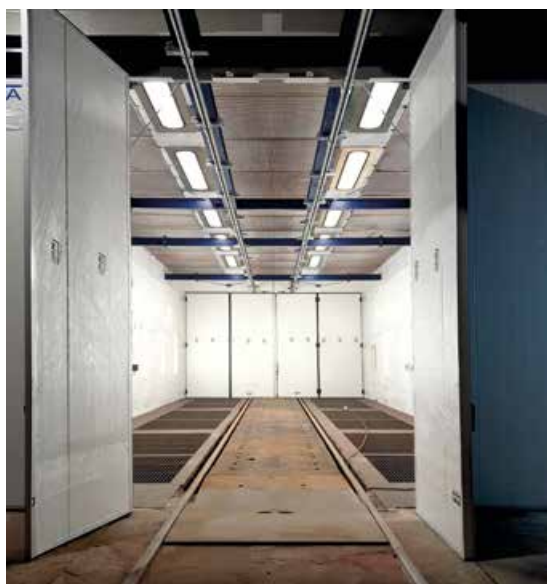
Zrekonstruovaná kabina a dopravník
