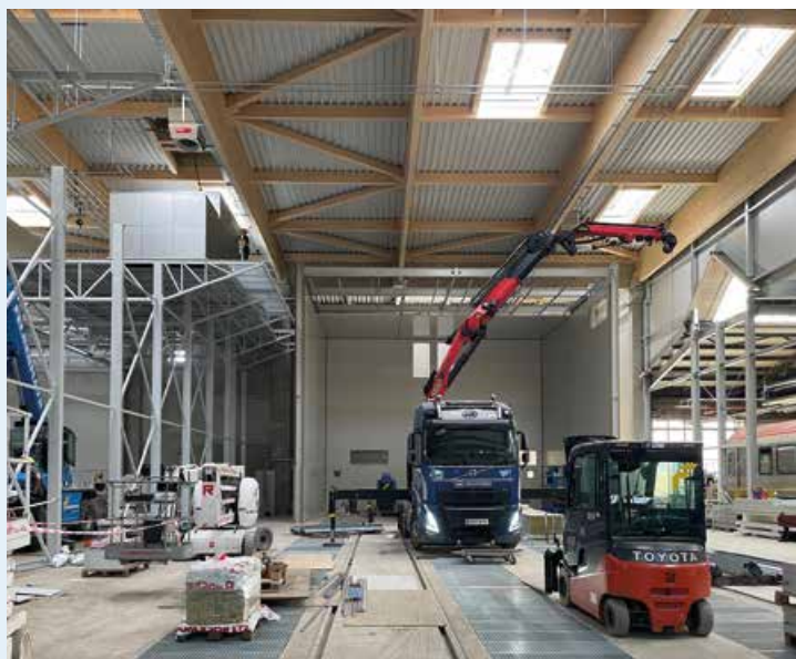
Montáž protipožárního sarkofágu
