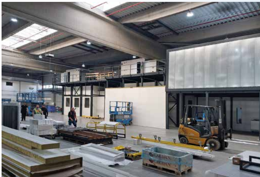
Průběh montáže v Povážské Bystrici
